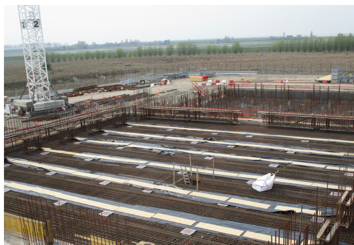
La dalle du futur SF 2 de Doel
